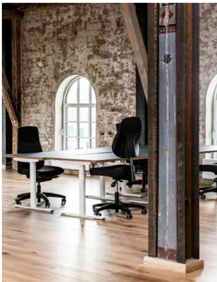
Havnegade 34, Odense Havn. Ejendommens originale trækonstruktion er forstærket med stål. Se også foto side 22.
