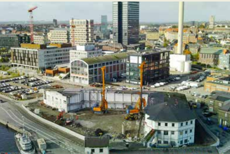
Procesfotos fra arbejdet på Mindet i 2022. Indvendigt har vi sandblæst gulve, vægge og de bærende betonsøjler. Udvendigt har vi slebet facaderne som klargøring for betonrenovering og gravet ud til tre lag jordankre for tårnet.
