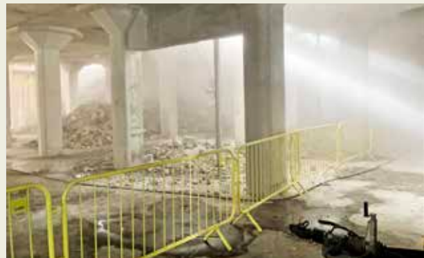
Procesfotos fra arbejdet på Mindet i 2022. Indvendigt har vi sandblæst gulve, vægge og de bærende betonsøjler. Udvendigt har vi slebet facaderne som klargøring for betonrenovering og gravet ud til tre lag jordankre for tårnet.
